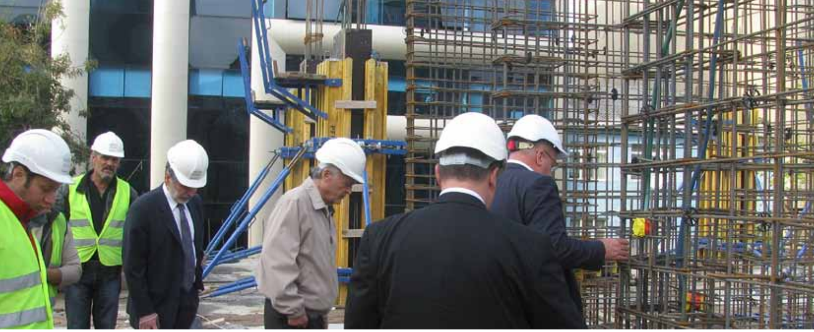
Proje Teknik Ekibinin Yeniden Yapım Çalışmaları Yerinde İncelemesi
