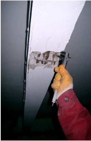
Şekil 5.4. Pas payı sıyrılarak belirlenen kiriş ve kolon donatısı ve detayları
