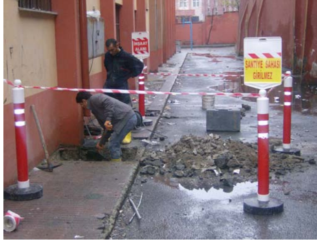
Şekil 5.2. Bina temelinde açılan bir inceleme çukuru
