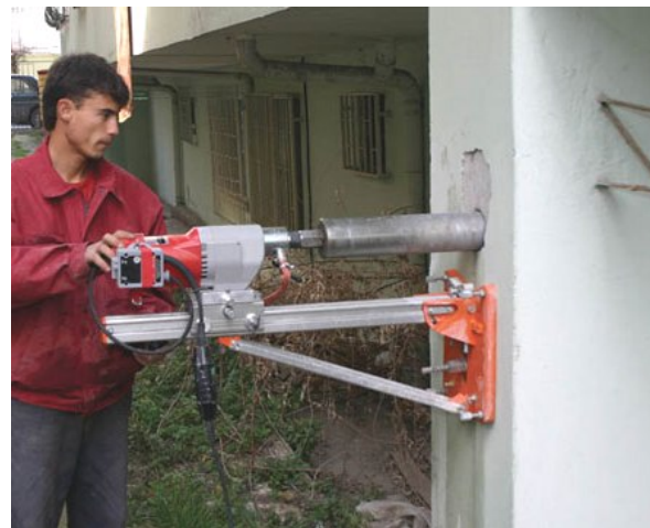
Şekil 5.6. Karot alma cihazı ile kolondan silindir beton örneği alınması
