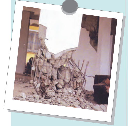
Şekil 4.10: Kolonlarda çekirdek betonun patlaması
