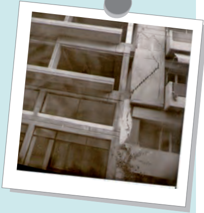
Şekil 4.19: Bitişik çok katlı binalarda görülen hasarlara bir örnek
