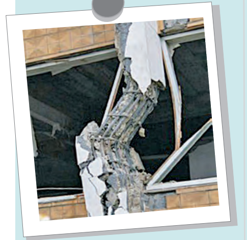
Şekil 4.11: Kolonlarda malzemenin kopması ve yamulması
