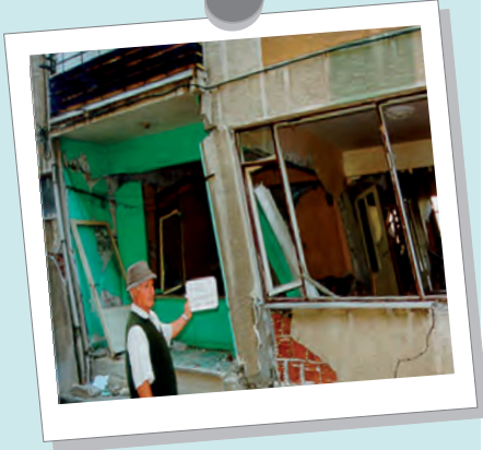
Şekil 4.13: Çatlamış veya ezilmiş kolon/kiriş bağlantıları
