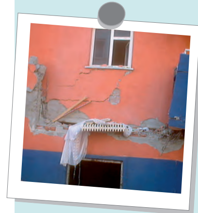
Şekil 4.17: Ara kat çökmesi meydana gelmiş bina örnekleri
