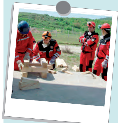
Şekil 12.9: Ahşap tahkimat çalışması
