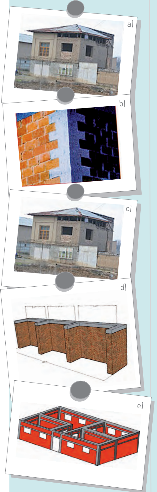
Şekil 4.8: a) Yığma bir binaya örnek b) Birbirine dik bağlanan taşıyıcı duvarların birleşimi c) Taşıyıcı duvarlarda sınırlanan değerden fazla açılan boşluklar d) Taşıyıcı duvar uzunluk sınırları ve yatay hatıl uygulaması e) Taşıyıcı duvarların plan yerleşimi ve bağlantıları
