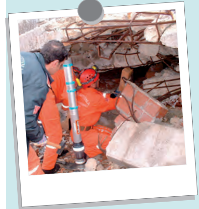
Şekil 12.8: Mekanik destek elemanı ile yapılan destekleme çalışması
