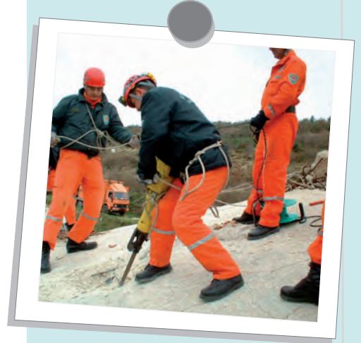
Şekil 12.2: Arama-kurtarma çalışmasında kırıcıyla delme işlemi
