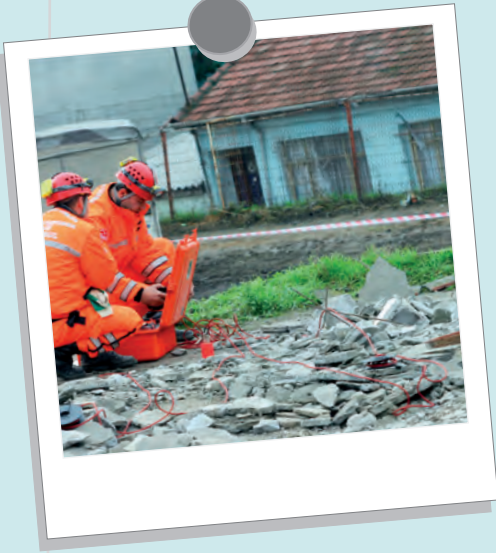
Şekil 11.3: Sismik ve akustik özellikli cihazlarla arama
