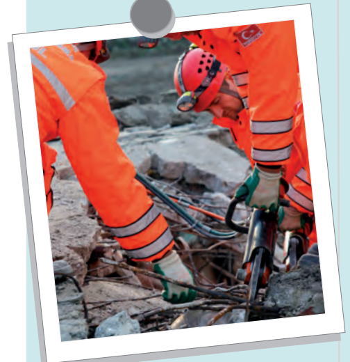
Şekil 12.3: Hidrolik kesme-ayırma aletiyle kesme çalışması
