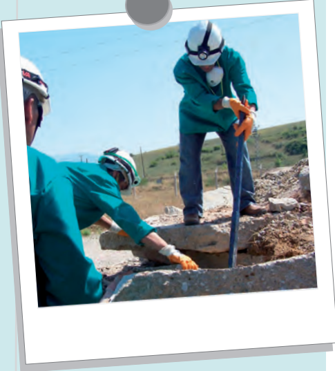
Şekil 12.5: Levye ile kaldırma çalışması
