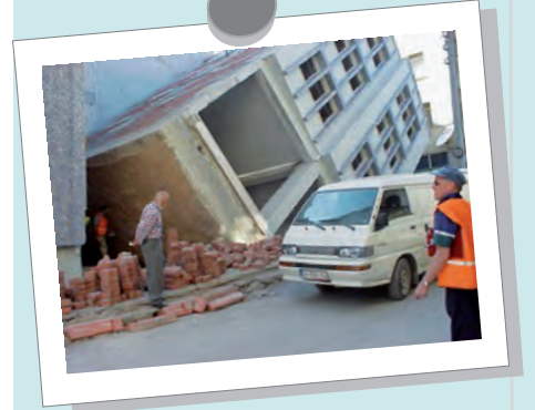
Şekil 4.16: Deprem sonrasında yan yatarak devrilmiş binalar
