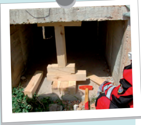
Şekil 12.13: Sıkıştırma takozları yardımıyla yapılan tek noktadan basit destekleme
