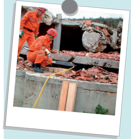
Şekil 12.7: Pnömatik destek elemanı ile yapılan destekleme çalışması
