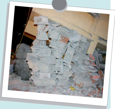
Şekil 12.14: Hatalı tahkimat uygulaması
