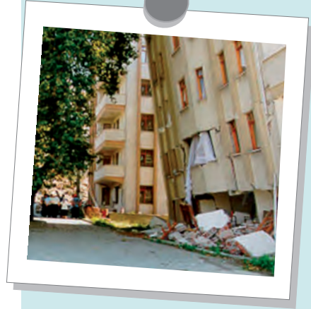
Şekil 4.15: Sivilaşma nedeniyle binalarda meydana gelen temel kaymaları ve oturması
