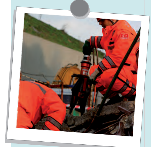
Şekil 12.4: Hidrolik kesme-ayırma aletiyle kesme çalışması
