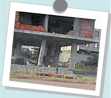
Şekil 4.14: Yumuşak katlı binalarda bulunan kolon ve kiriş bağlantı yerlerindeki hasarlar
