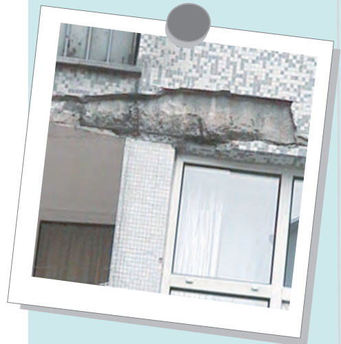
Şekil 4.12: Kolon veya kirişlerde kabuk dökülmeleri
