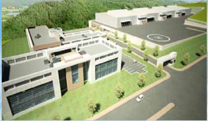
Akfırat Komuta Kontrol Merkezi
