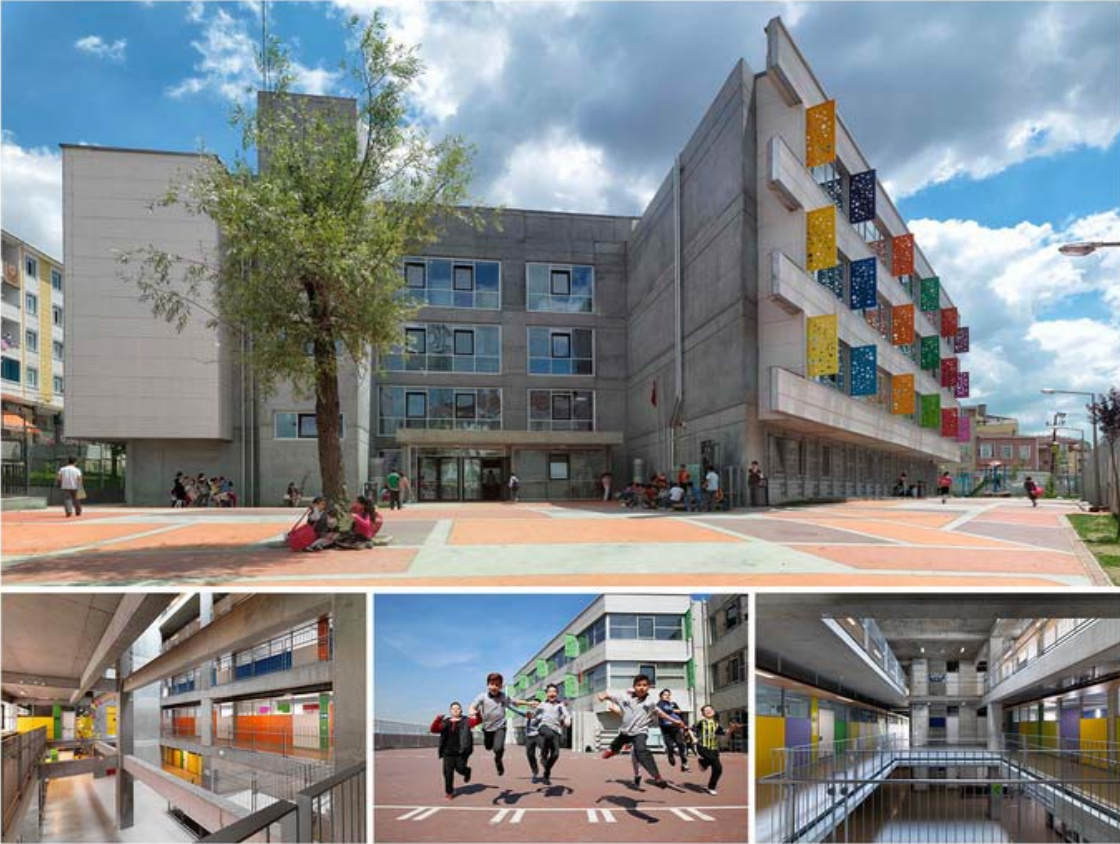
Resim B. İSMEP kapsamında yeniden inşa edilen okul
