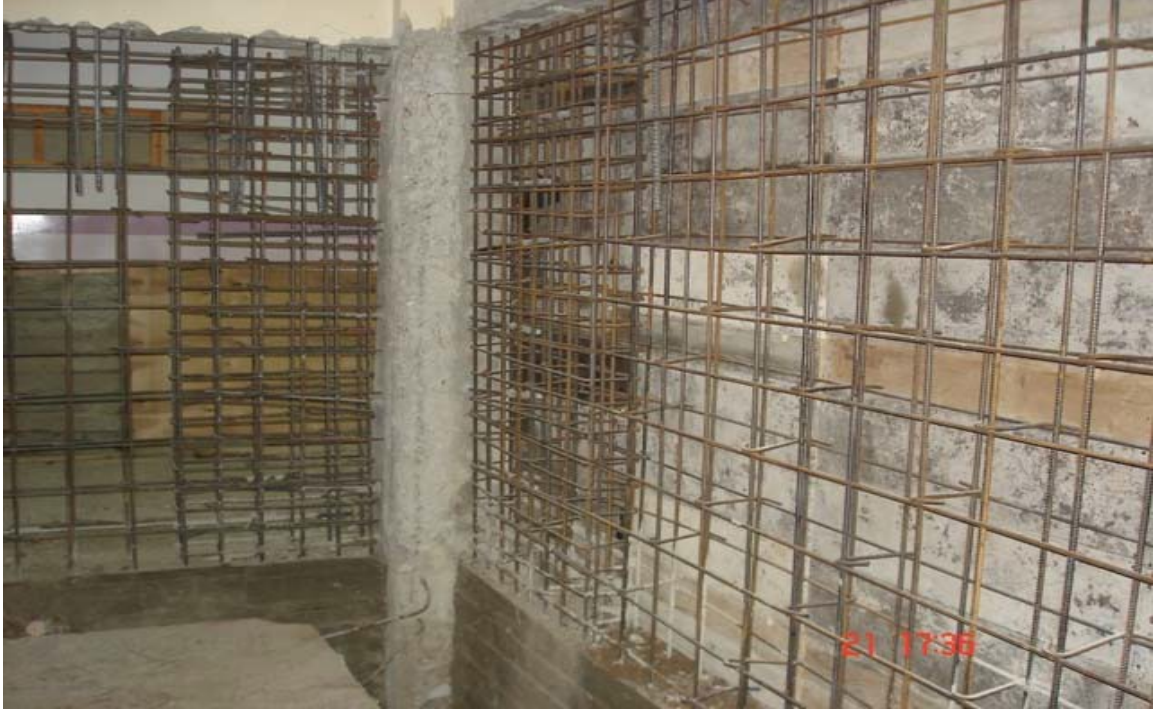
Resim C. İeriden Betonarme Perde Duvar (okul glendirme)
