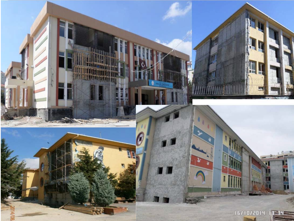
Resim D. Dışarıdan Betonarme Perde Duvar (okul glendirme)
