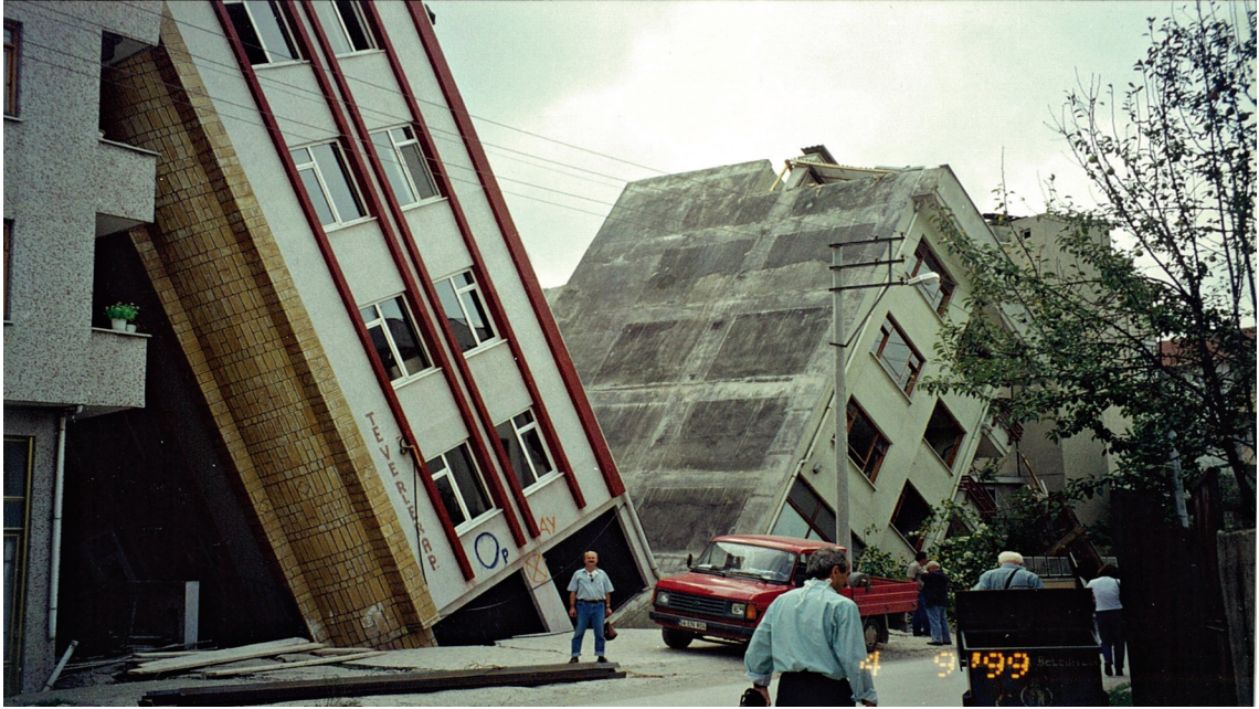
Resim 2. Zemin Özelliklerini Dikkate Almayan Yapılaşma (İnşaat Mühendisleri Odası İstanbul Şubesi Arşivi).
