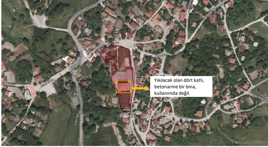
Yapısal olarak yetersiz bulunan eski okul binası yıkılacaktır.
