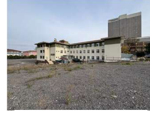
Elektrik atölye binası
