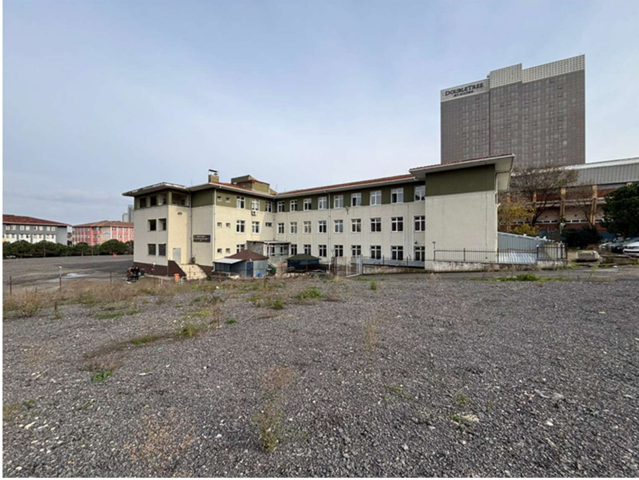
Fotoğraf 2: Elektrik Atölyesi Binası
