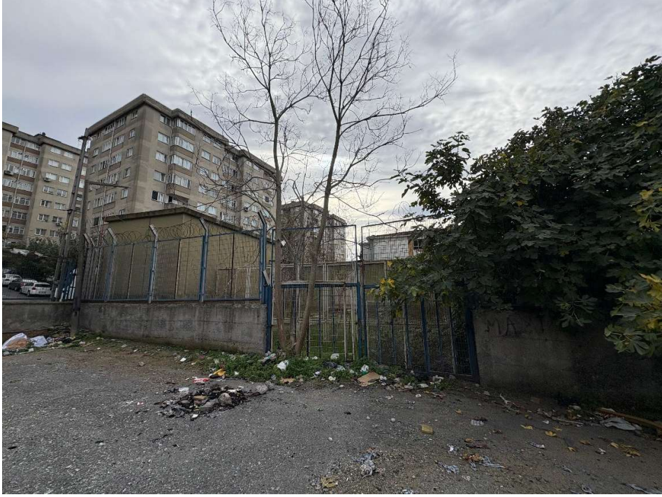
Fotoğraflar 11: Proje Alanı Çevresi/ Transformator
