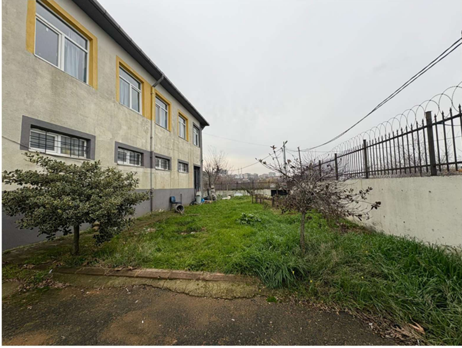
Fotoğraf 3-4-5: Okul Binası
