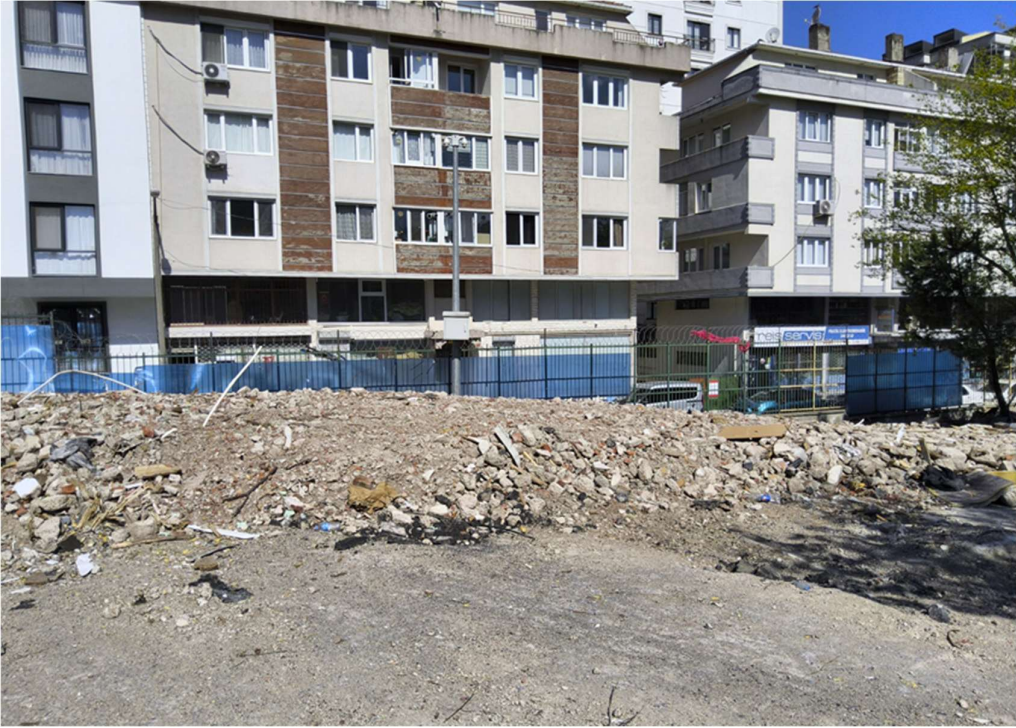
Fotoğraf 8, 9, 10: Eski Personel Konut Binalarının (Yıkılmış) Bulunduğu Alan
