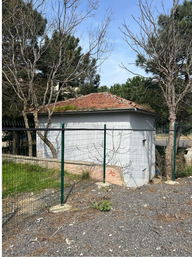
Fotoğraf 6: Trafo Binası
