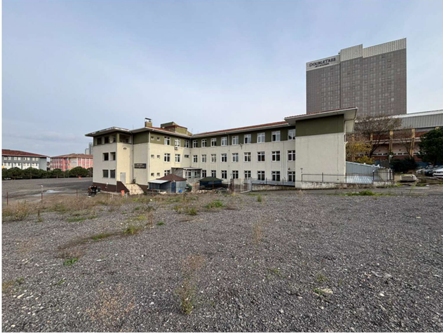
Fotoğraf 2: Elektrik Atölyesi Binası
