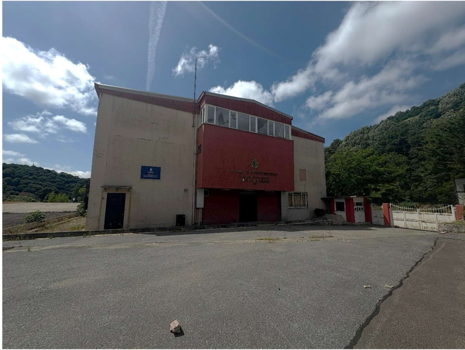
Fotoğraf 8-9: Proje Alanı ve Diğer Yapı – Spor Salonu (alt proje kapsamı dışında ve korunacak)
